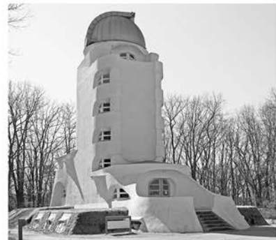
Observatorium im „Einstein-Turm“ in Potsdam
