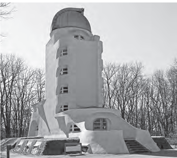
Observatorium im „Einstein-Turm“ in Potsdam
