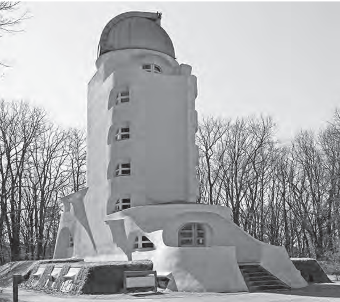
Observatorium im „Einstein-Turm“ in Potsdam
