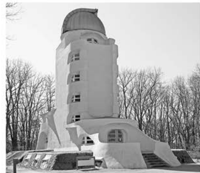
Observatorium im „Einstein-Turm“ in Potsdam
